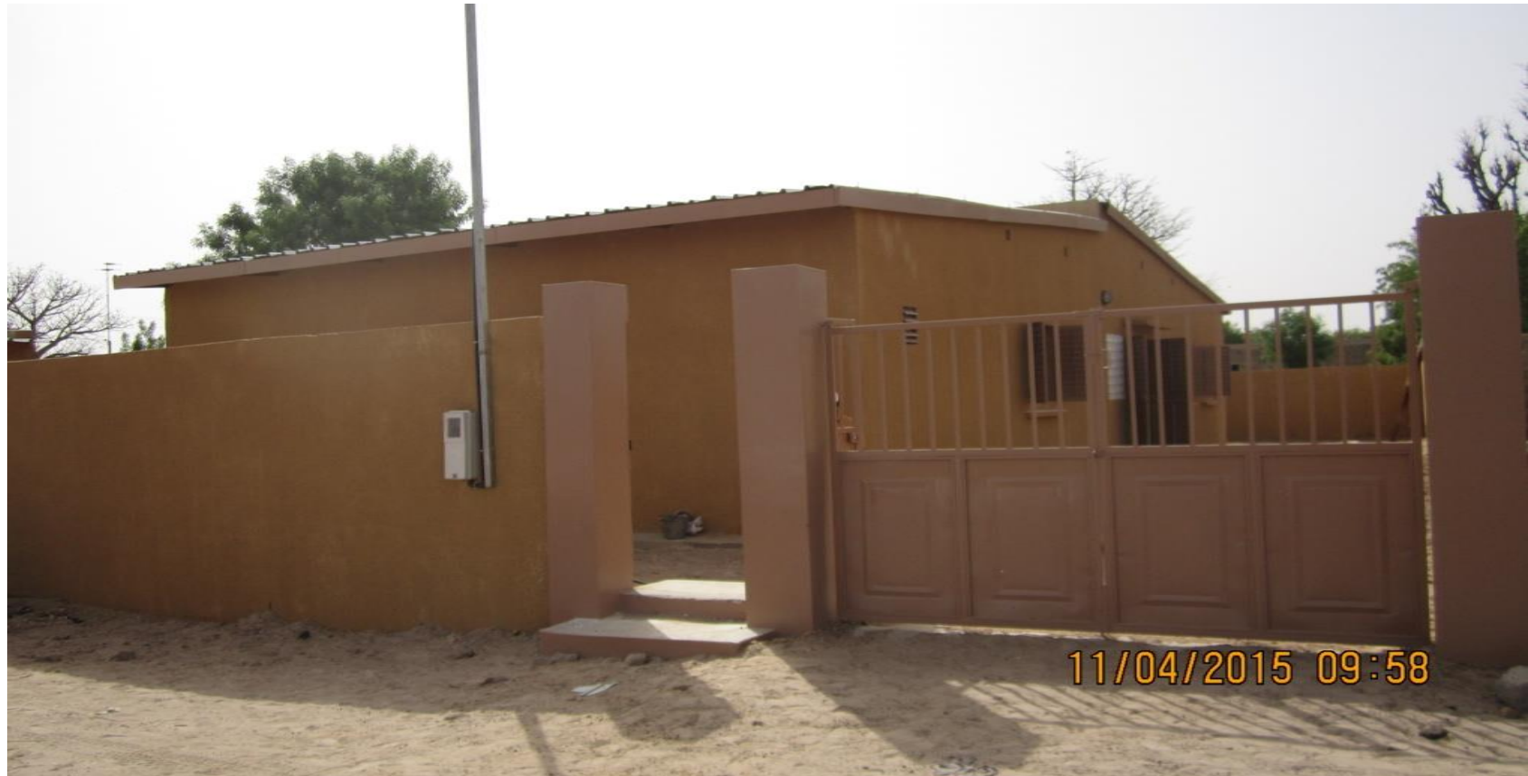
Dispensaire et salle d'accouchement construits et équipés à Guinguinéo
